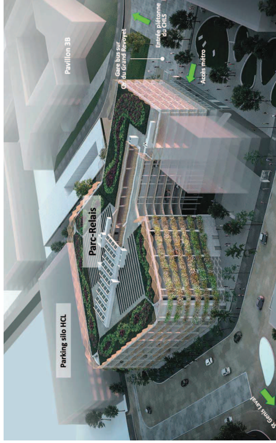
Vue axonométrique de la station de métro avec le parc-relais situé au-dessus (source : SYTRAL)
